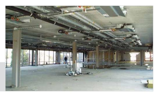
Система встроенных межэтажных перекрытий INODEK. Простая и экономичная установка инженерных сетей.
